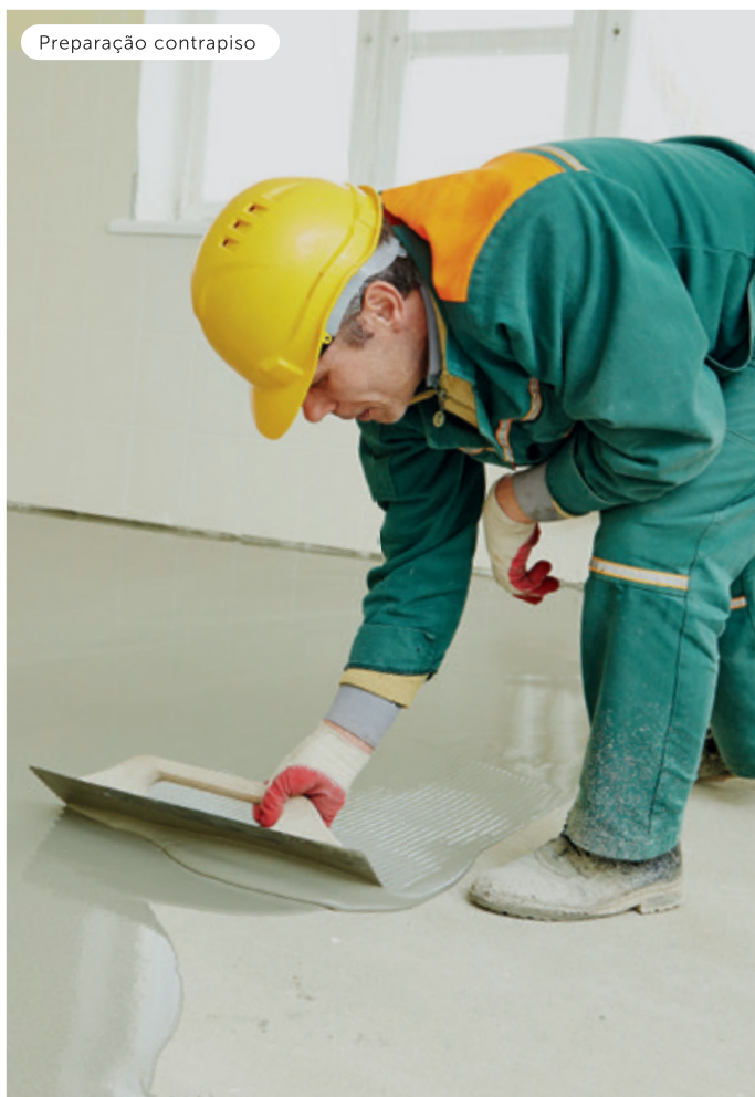
Instalação | Piso vinílico
